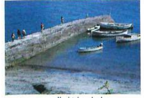
لسان داخل البحر liṣān dāḥil al-baḥr der Landungssteg
